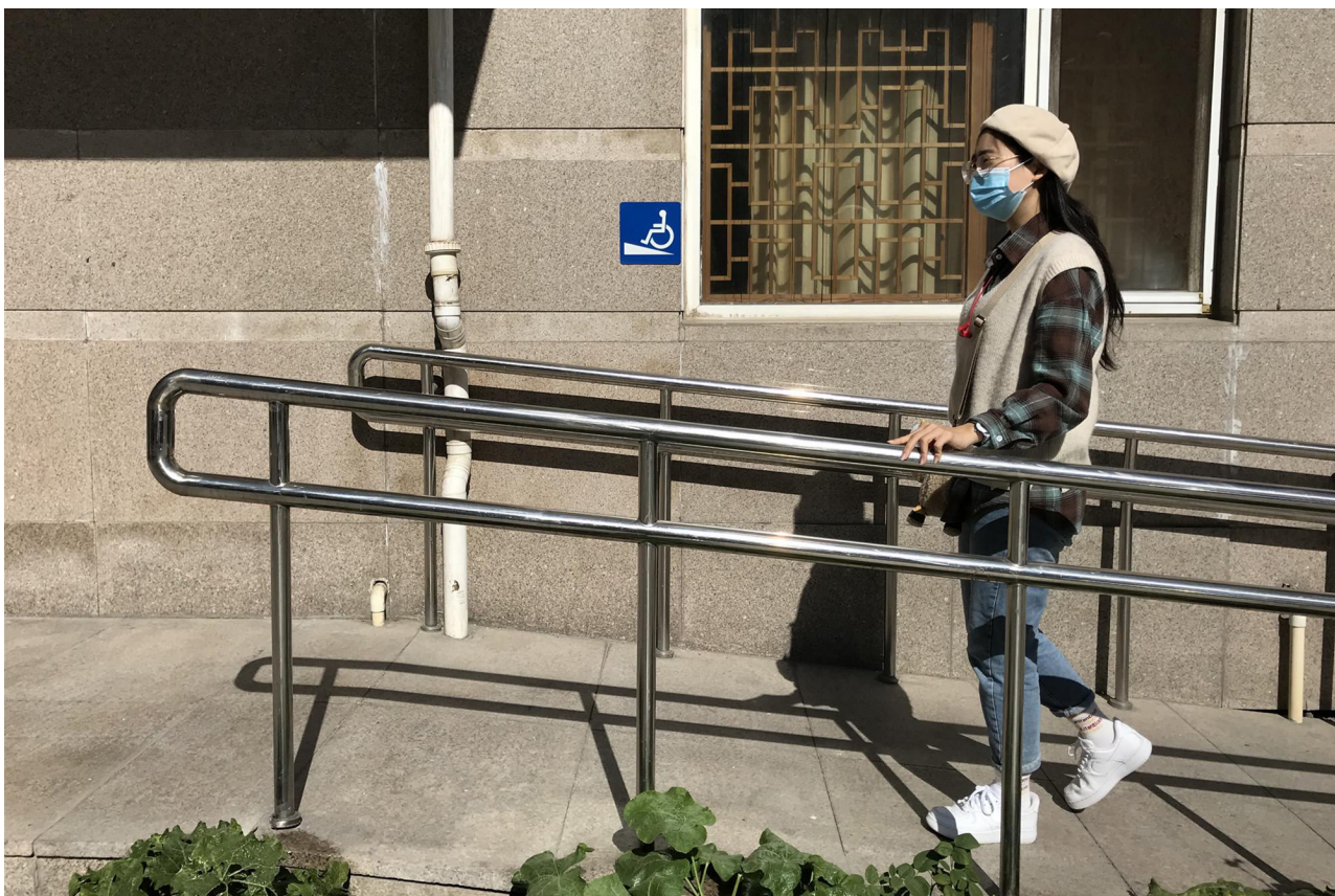
图 20：改造后的无障碍坡道
