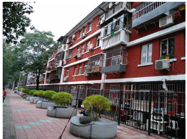
图 17：老旧小区改造后
