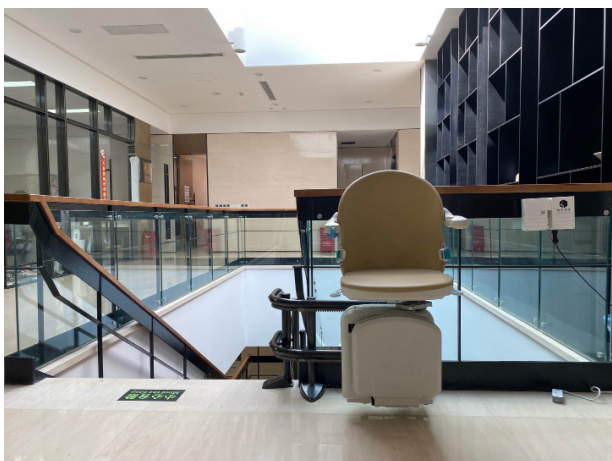
图 21：改造后的无障碍设施
